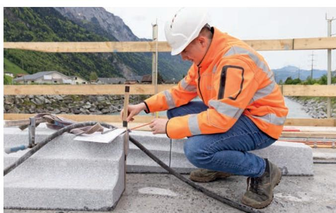
^ Misurazioni sul posto Spesso nei cantieri si utilizzano misuratori laser. Talvolta, però, si ricorre ancora al buon vecchio metro pieghevole, ad esempio per controllare le altezze.
